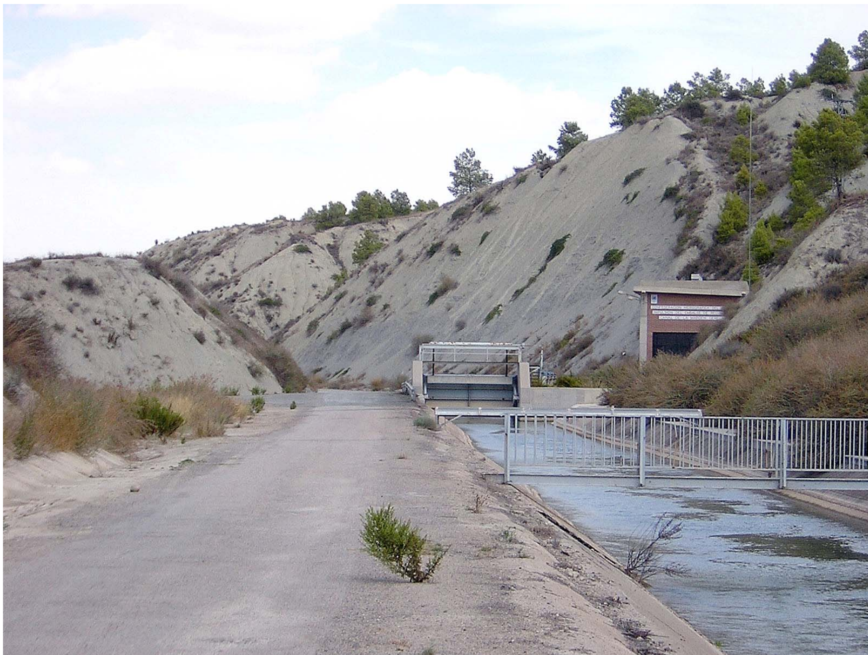
26-37-IN-FL-F 33.- Aspecto de las margas azules (30), en el Canal del Taibilla. Vertiente septentrional de la Sierra de La Muela
